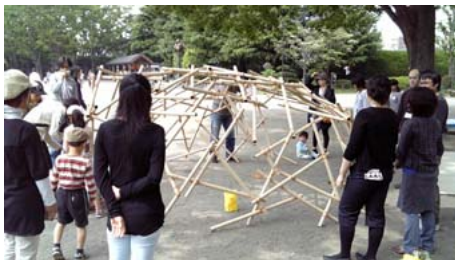
パーツを繋ぎ組み上げる
