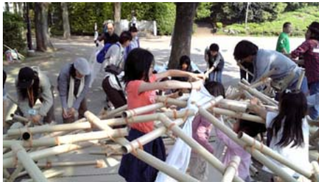
解体作業風景
