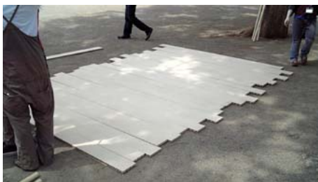
ダンボールのフローリング敷設
